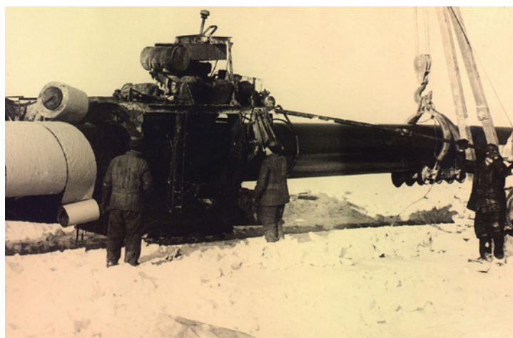
Строительство газопровода Бухара–Урал, 1965 год
