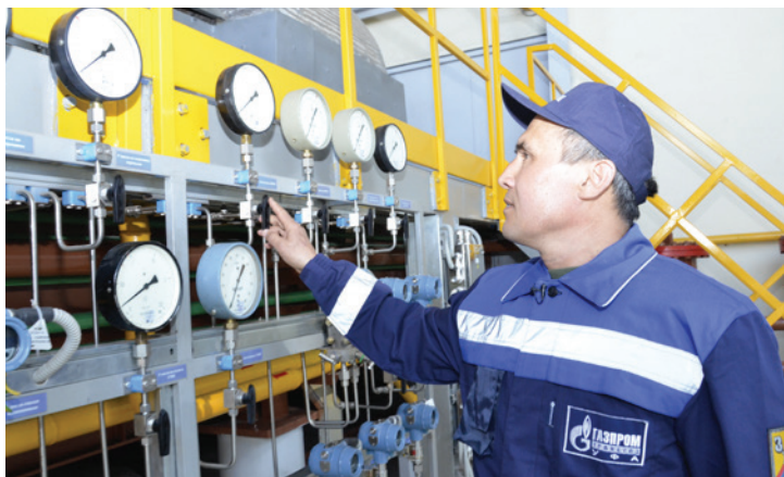
Тагир Салихов на компрессорной станции
