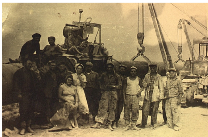
Строители магистрали на плато Устюрт
