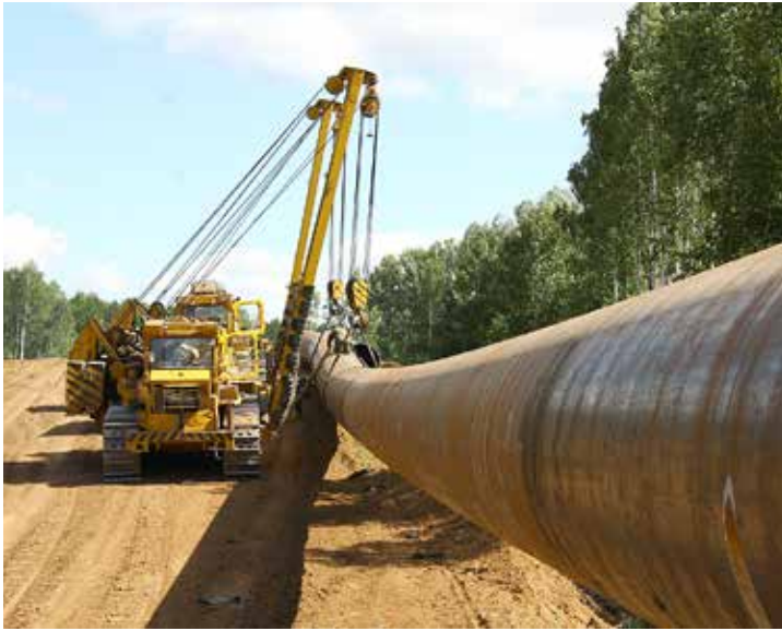
Трубопроводчики должны назубок знать свою трассу
