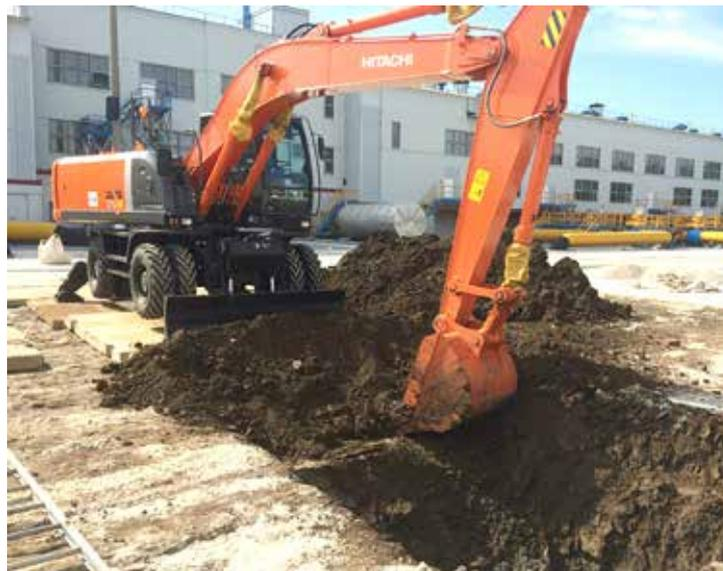
*Шурфовая диагностика технологических трубопроводов в ДЛПУМГ*
