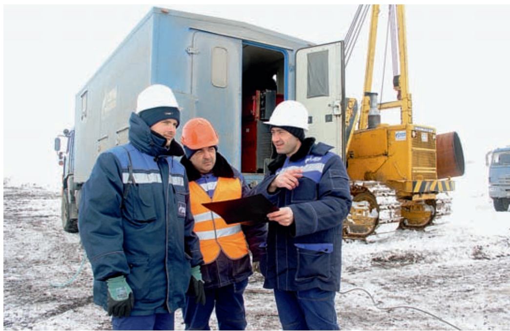
Идет обсуждение плана работ по ремонту участка газопровода специалистами Аркауловского ЛПУМГ
