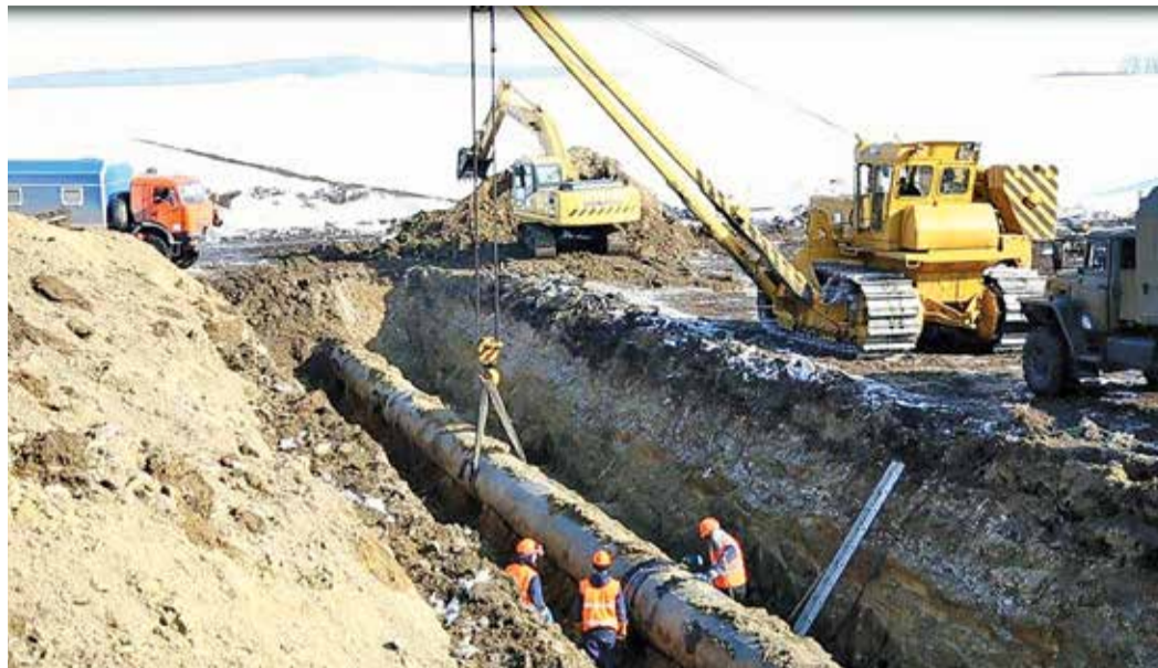
Работы на участке магистрального газопровода Челябинск–Петровск
