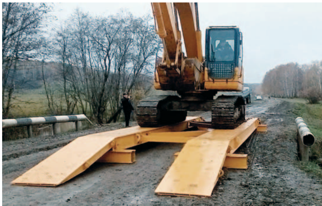
Мостовой колеевый настил способен выдержать временную нагрузку массой до 55 тонн
