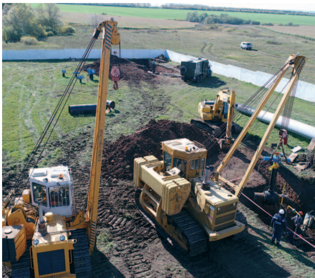
Ремонт камер приема и запуска очистных устройств газопровода Поляна-КСПХГ в Стерлитамакском районе производился впервые
