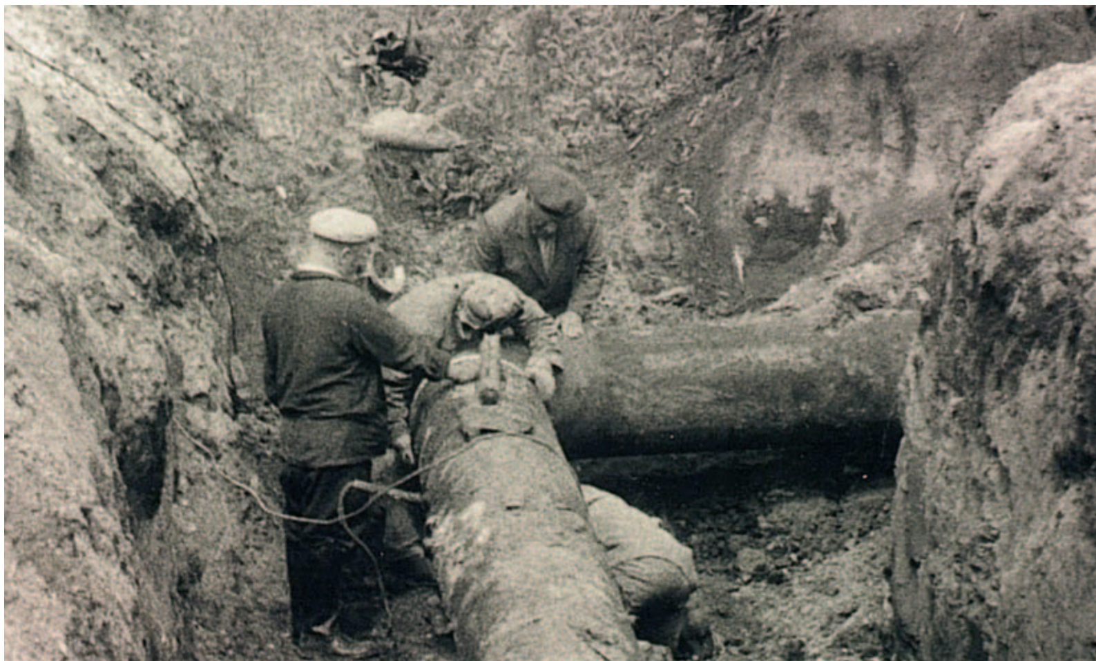
На строительстве газопровода Шкапово–Ишимбай
