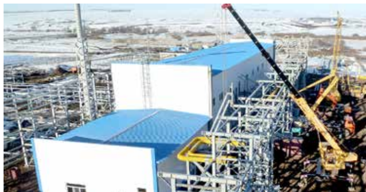
Площадка СП-2 Канчурино-Мусинского комплекса ПХГ
