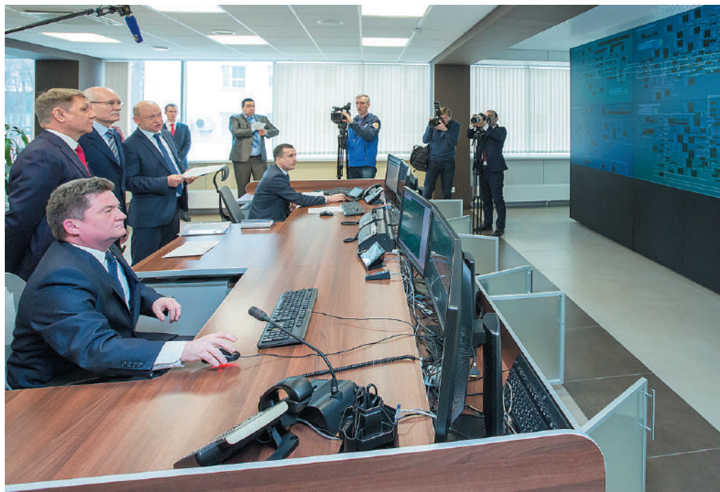
Система производственно-диспетчерского управления – гордость ООО «Газпром трансгаз Уфа»
