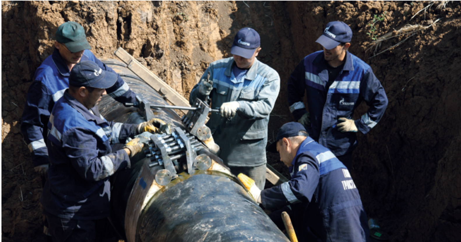
Ремонтные работы на участке газопровода-отвода к ГРС Карманово (Дюртюлинское ЛПУМГ, август 2010 года)
