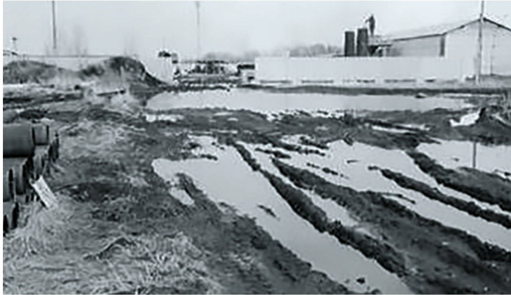
Строительство промплощадки Сибайского ЛПУМГ
