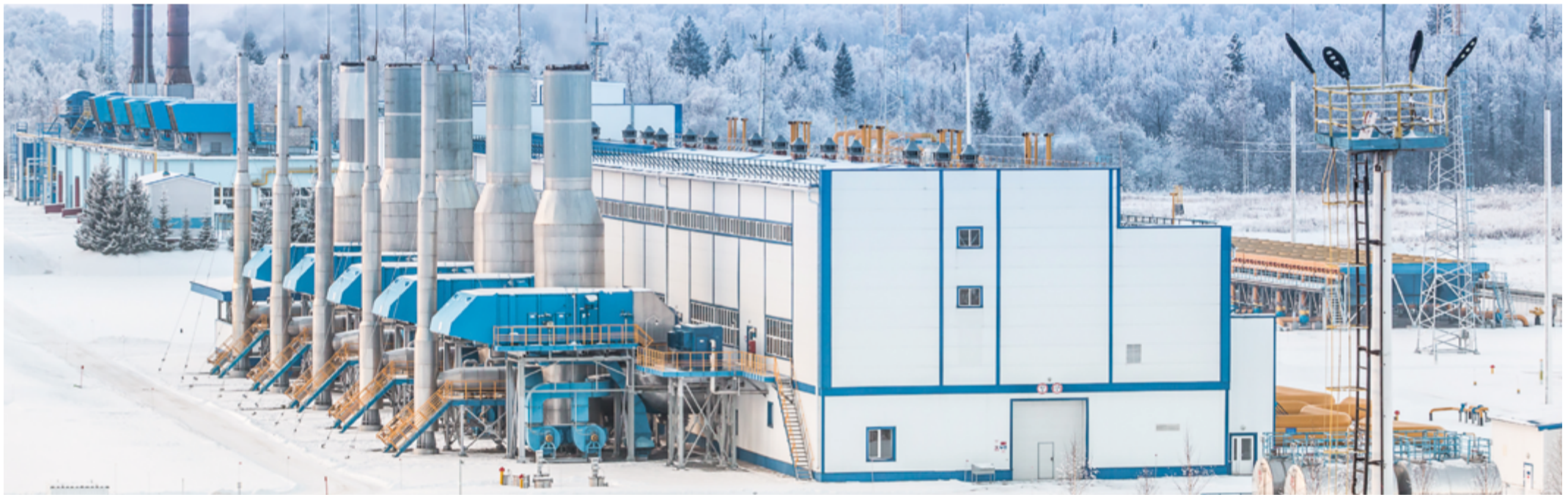
В транспортировке газа задействованы современные компрессорные станции
