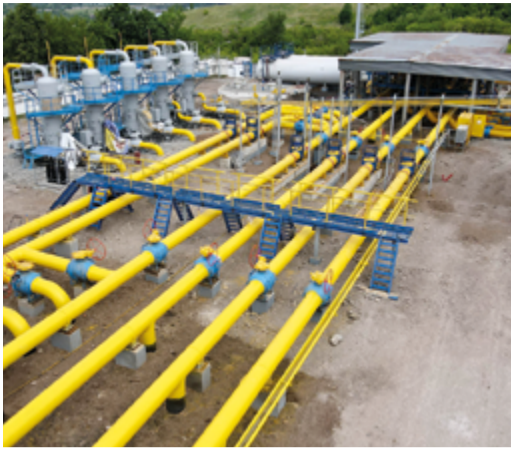
На площадке ГРС-3 Ново-Александровка
