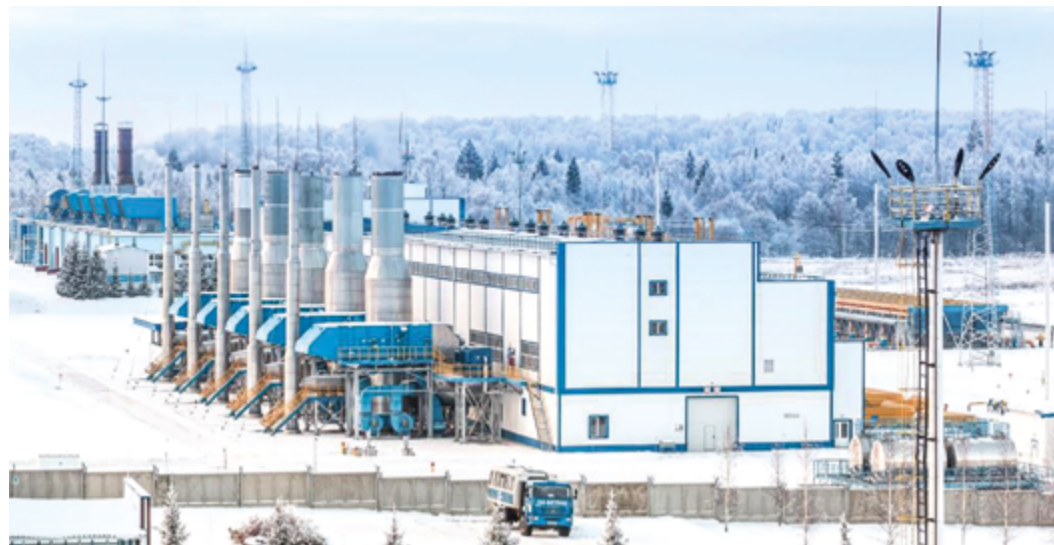
Минувший осенне-зимний период испытал на прочность Единую систему газоснабжения
