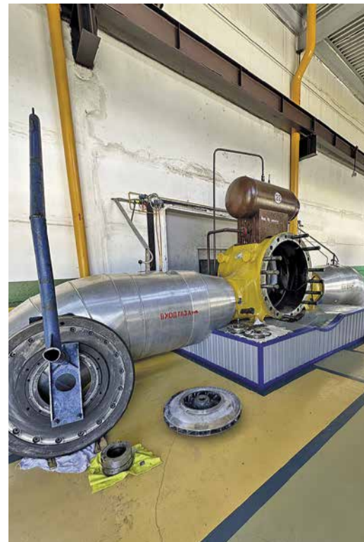
Оборудование в процессе ремонта
