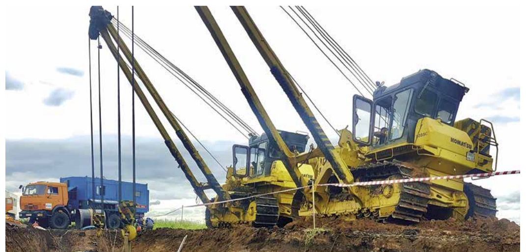
В процессе устранения дефектов
