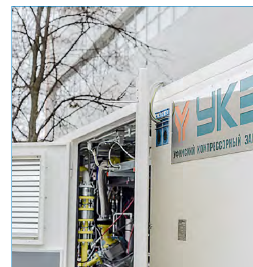
Отсек панели приоритета
