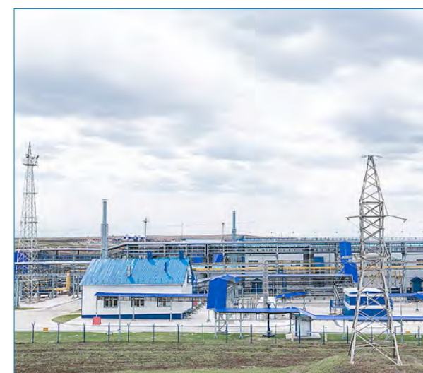
Насосная станция и водозаборные сооружения
