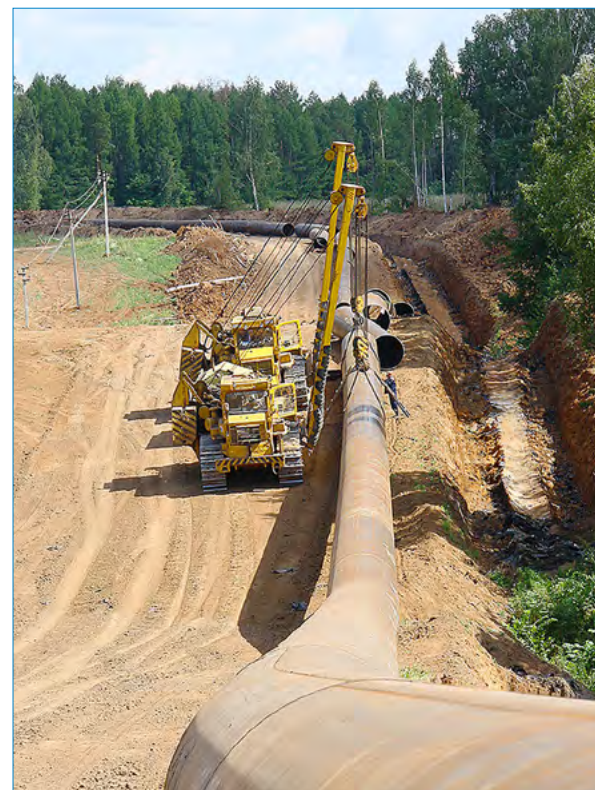
Капитальный ремонт на газопроводе Поляна–КСРХГ
