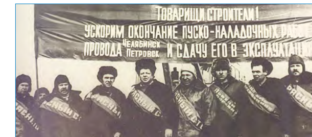
Строители газопровода Челябинск–Петровск
