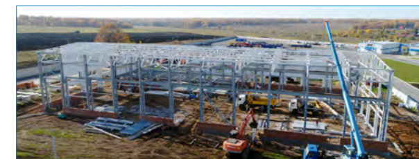
Строительство теплой стоянки спецтехники и дорожно-строительных машин
