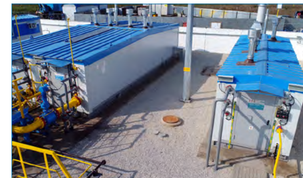
Блок подготовки теплоносителя ГРС Тюрюшля
