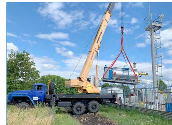
Монтаж подогревателя газа ПГ-30-1,08-7,5-У1 на ГРС Бuzовьязы
